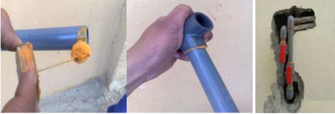
شكل (4) لحام الماسورة وتثبيتها بالجدار
