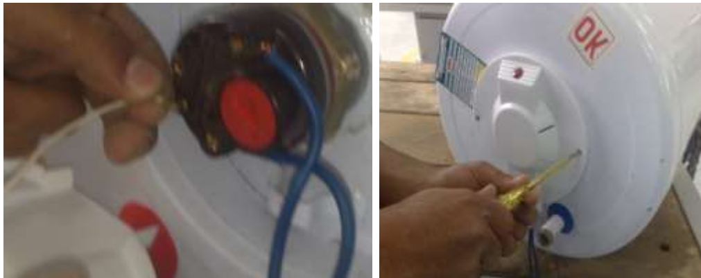
شكل (8-11) توصيل اسلاك الكهرباء ولمبة البيان
