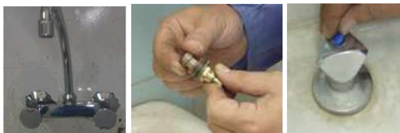
شكل (3-5) اجزاء الخلط الانضغاطي
