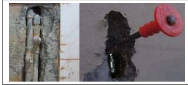
شكل (2): التفريغ حول الانابيب التالفة
