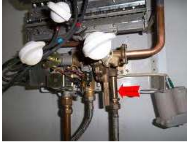
شكل (2-8) الاجزاء الداخلية لسخان الغاز
