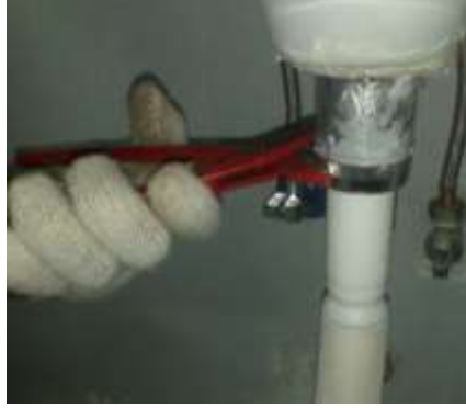
شكل (3-7) فك السيْفون بواسطة الزردية
