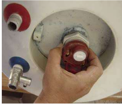
شكل (8-10) ادخال التيرموستات في القلب
