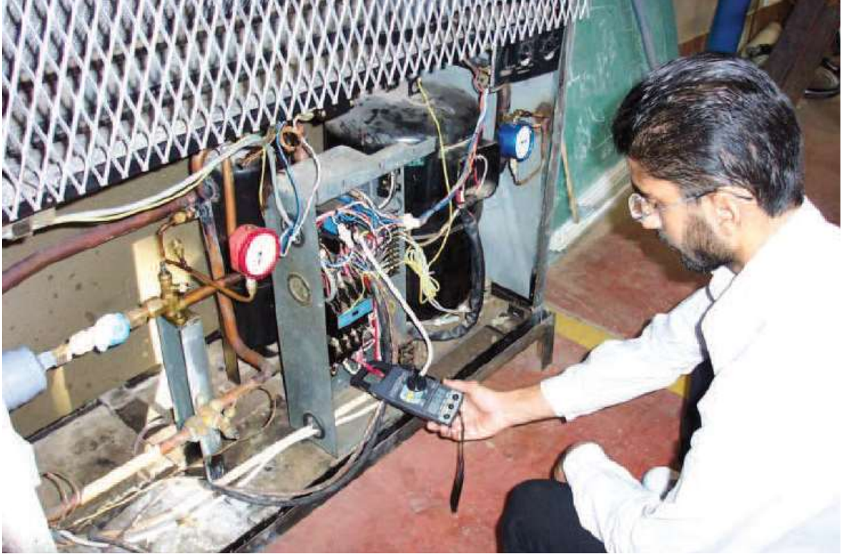
شكل(17) صيانة وحدات التكييف المجمعة
